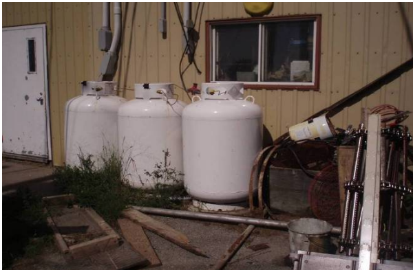
Exemple d'installation non conforme de bouteilles
